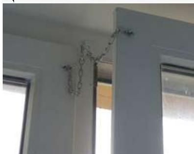
Цепочка крепится в верхней части окна, блокирует поворотную функцию окна, оставляя возможность использовать откидное положение. При этом проветривание комнаты обеспечено. Старый, но надежный способ.
